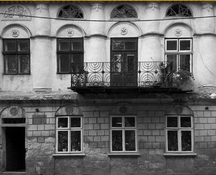
Bariera balkonu wykonana z balustrady przedwojennej bimy
