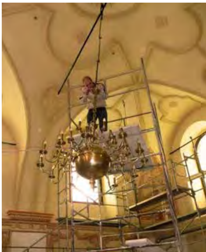
Synagoga w Zamościu, prace wykończeniowe
