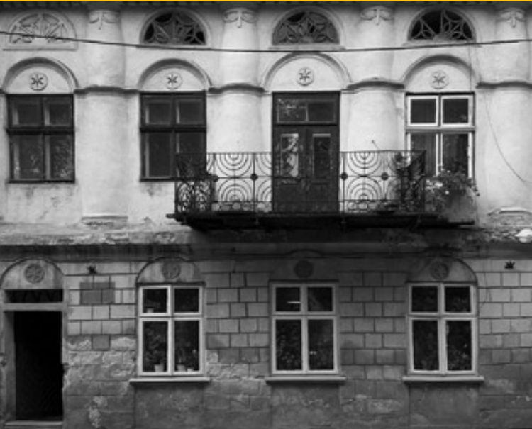
Bariera balkonu wykonana z balustrady przedwojennej bimy
